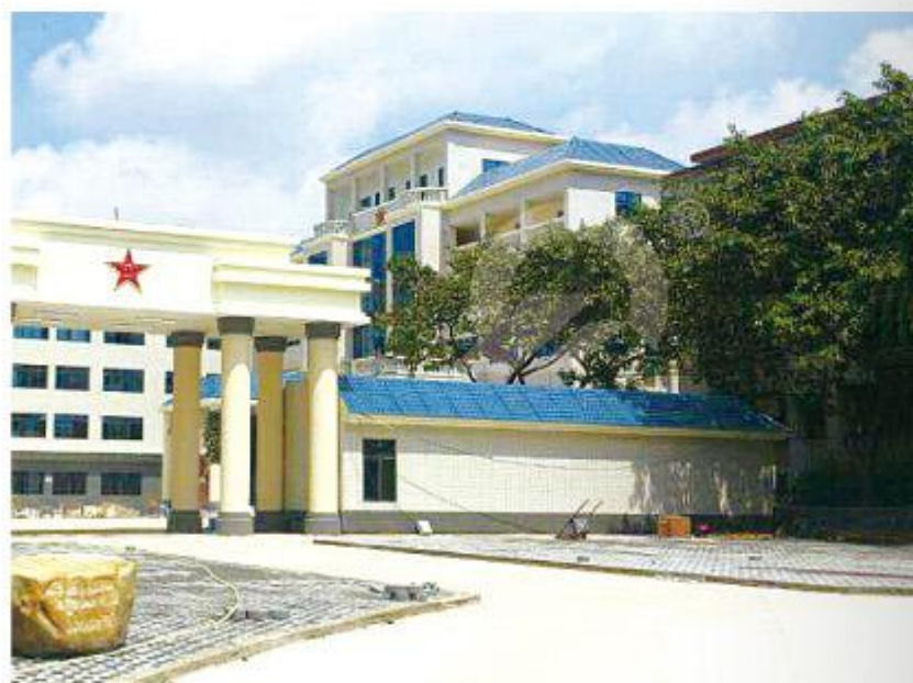
某部队平改坡(蓝灰色)
