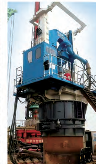
澳沙四桥 直径2.8米、深度119米桩基施工
