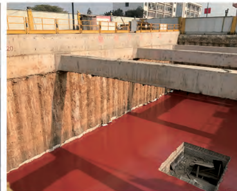
咬合桩开挖效果 Result of secant pile wall
