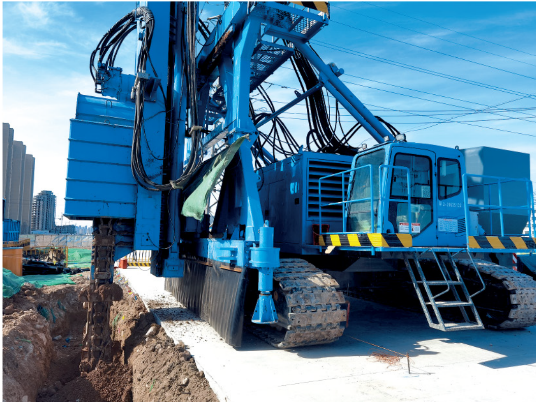
青岛地铁，槽宽900，深度45米 Qingdao Subway, Width 900m, Depth 45m
