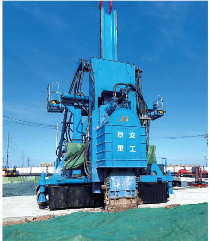
青岛地铁，槽宽900，深度45米 Qingdao Subway, Width 900m, Depth 45m
