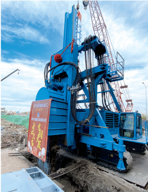
天津北辰，槽宽650，深度55米 Tianjin Beichen, Width 650m, Depth 55m
