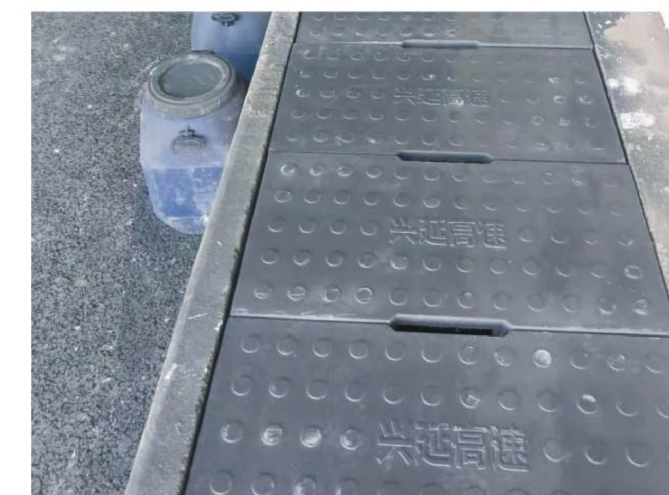
北京兴延高速 (世界园艺博览会重点配套工程)
